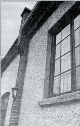
Byggmester Alf Humlebekk har gjort en utmerket jobb med trevaren, og har bl.a. beholdt de gamle, flotte «mur-ornamentene».
